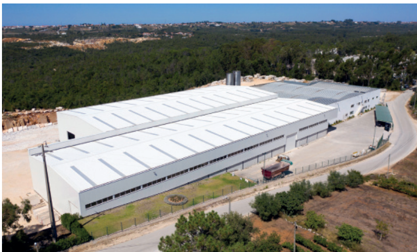
Das Werksgelände von Airelimestones misst 7.200 m 2 . Die Halle ist mit modernsten Produktionsanlagen ausgerüstet. Fotos: Firma
