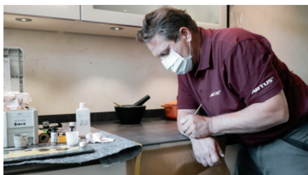
Zunächst wird ein Grundfüllstoff in den Untergrund eingebracht.
