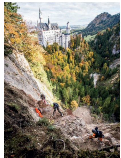
Fels- und Ankerbohrungen Fotos: Firma
