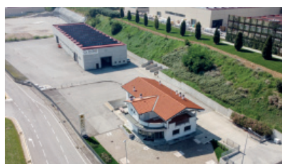
Der neue Standort von Ca' D'ORO in Cavaion Veronese liegt verkehrsgünstig an der Hauptstraße. Fotos: Firma
