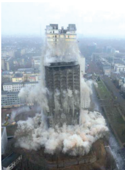
Europas größte Bauwerkssprengung: Sprengung des 117 m hohen AFE-Tower in Frankfurt
